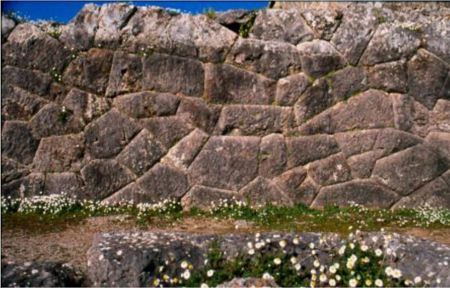
Fig.277.Muro poligonal del Nekromateoin de Efira
